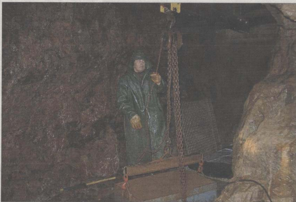
Le déblaiement d'un puits montant en surface.
